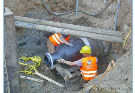
Reduzierung mit HP-Flansch Reducer with HP flange
