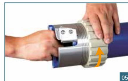
Halten Sie die Anfasglocke am Griff in Position und drehen die Überwurfmutter von Hand im Uhrzeigersinn, bis sich die Anfasglocke spielfrei auf dem Rohr zentriert hat.
