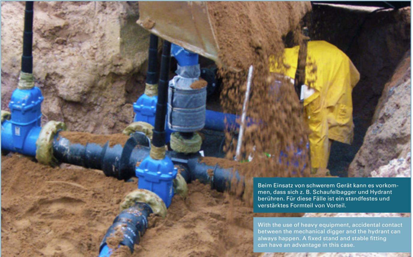
Beim Einsatz von schwerem Gerät kann es vorkommen, dass sich z. B. Schaufelbagger und Hydrant berühren. Für diese Fälle ist ein standfestes und verstärktes Formteil von Vorteil.
