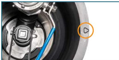
Die Fließrichtung kann an dem Pfeil auf der Stoßseite des Doms nach Demontage des Deckels abgelesen werden.
