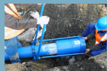
Verlegegerät für REINOGRIP Installation tool for REINOGRIP
