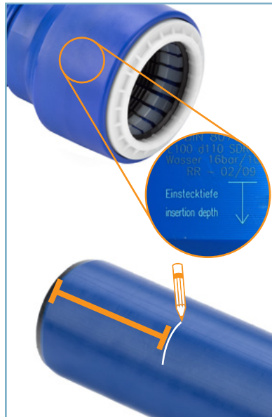
Die Einstecktiefe, mit Hilfe der Angaben auf der REINOGRIP Muffe, anzeichnen. ... mark the insertion depth.
