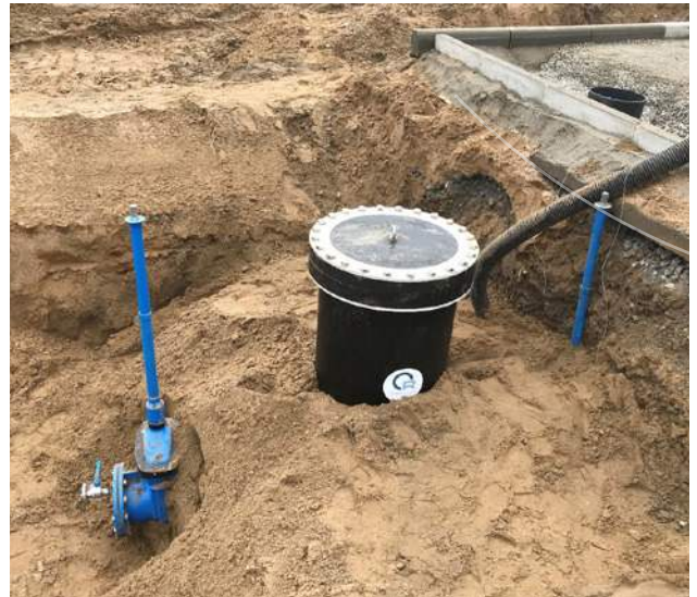
Bild 6: Anschluss folgt, Übergang der Rohwasserleitung in den Bauabschnitt 2
