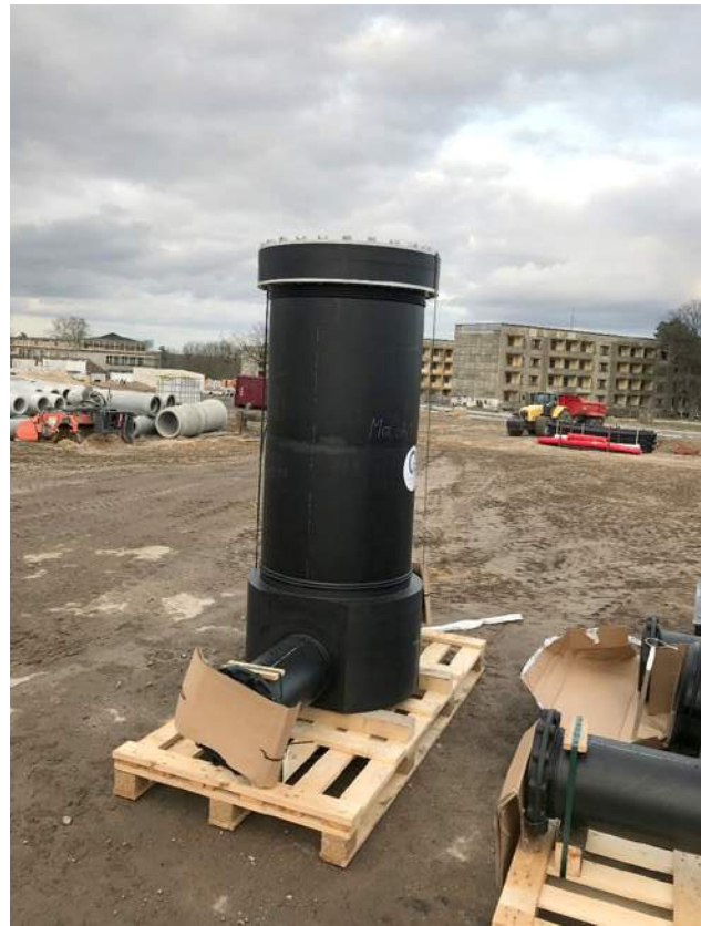
Bild 3: Ankunft der Molchstation auf dem Baustellengelände des ehemaligen Olympischen Dorfes in Berlin
