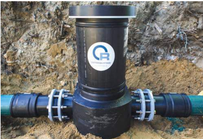
Nachträglicher Einbau in Leitung abgeschlossen – nun folgt der Probelauf.
