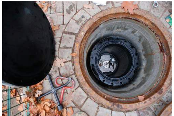
Zugang zur Molchstation von der wiederhergestellten Geländeoberkante aus
