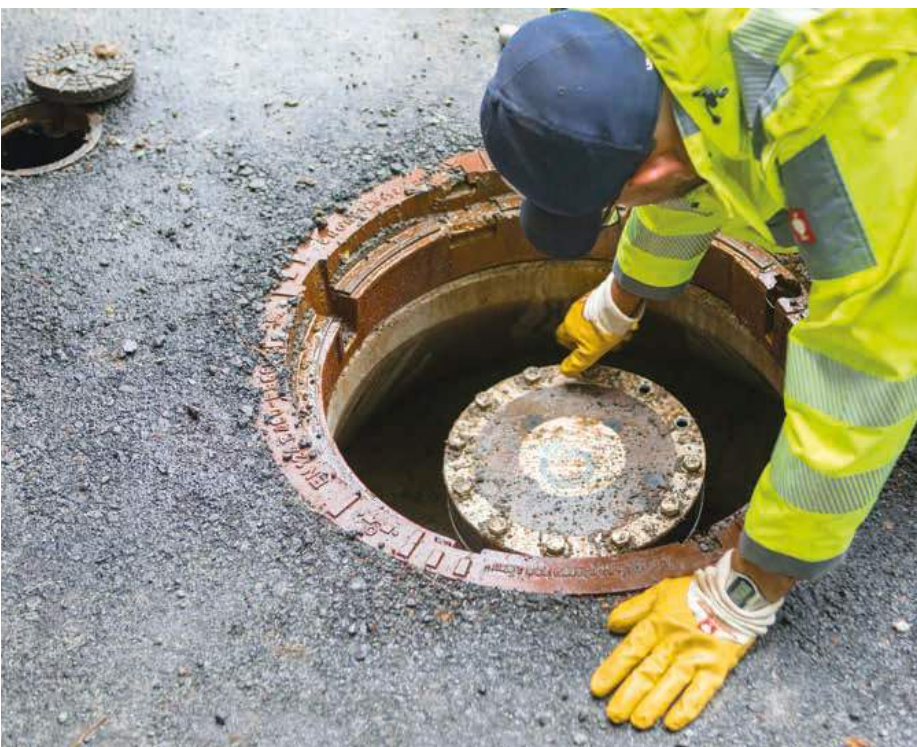
Vorbereitung der Molchung über Molchschleuse Quick-Pig d 75 mm SDR 11 beim ZLS Lollar, hier: Sendestation | Fotos: Reinert Ritz GmbH
