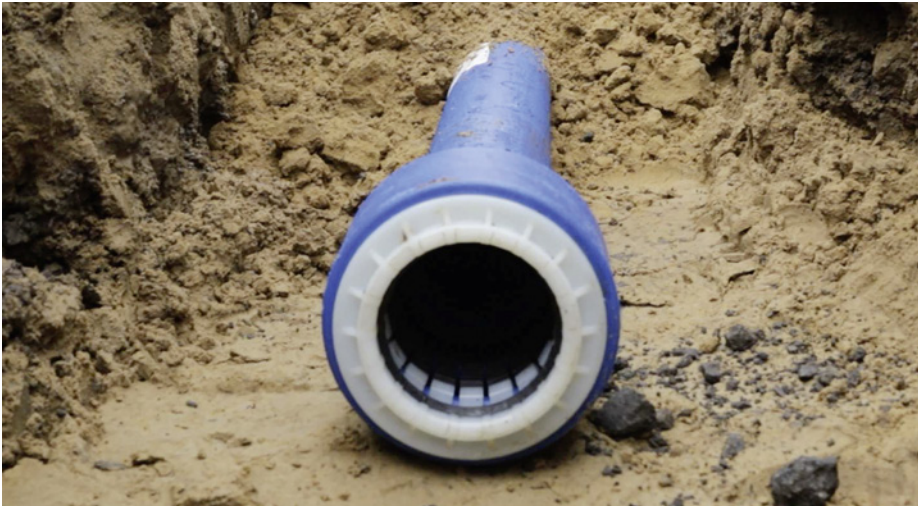
Verlegung des egeMDR-Muffendruckrohrsystems aus PE von egeplast mit Reinogrip-Steckmuffe von Reinert-Ritz
