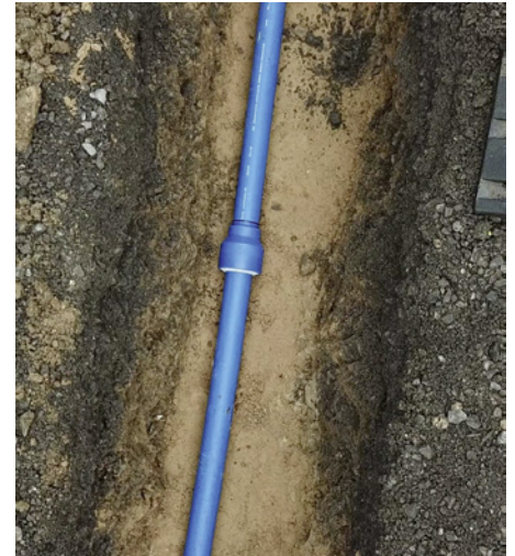
Verlegung des egeMDR-Muffendruckrohrsystems aus PE von egeplast mit Reinogrip-Steckmuffe von Reinert-Ritz
